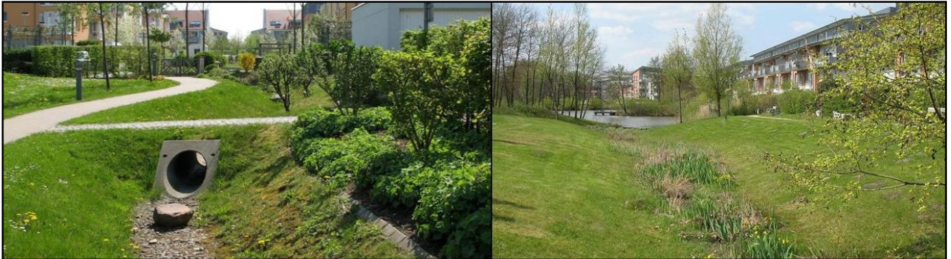
Kuva 5. Hulevesien johtamista avo-ojassa ja viherpainanteessa. Kuvat Saksasta, Hannoverista. 7
