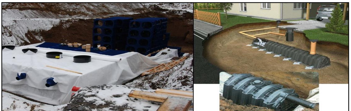
Kuva 6. Maanalaisia viivytysjärjestelmiä. Vasemmalla suurempi, noin 300 m 3 Wavin Labkon viivytyskennosto rakenteilla kerrostaloalueelle 6 ja oikealla Uponorin mm. pientaloon soveltuva hulevesitunneli 7 .
