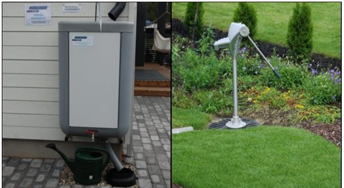
Kuva 7. Vasemalla esimerkki 190 litran kattovesisäiliöstä. Oikealla tontin hulevesille varattu kaivo, josta vedet pumpattavissa hyötykäyttöön. (Tampere, Vuores) 7
