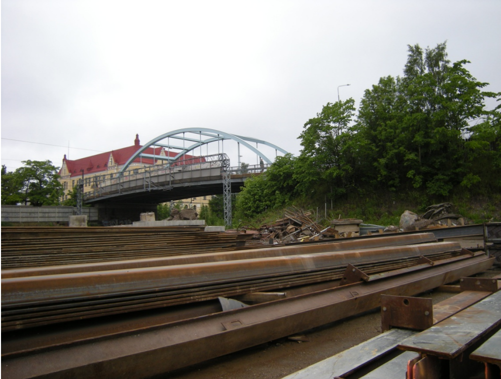
Kuva 3. Metallipalkkeja alueen pohjoispäässä Erkkilän sillan lähellä.
