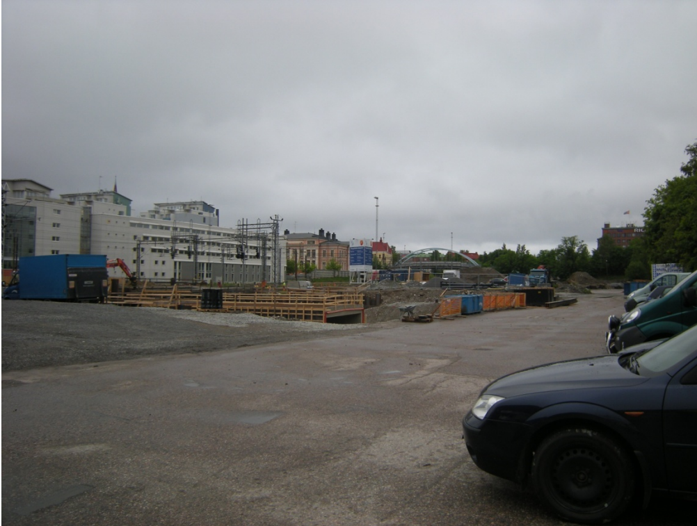
Kuva 1. Rongankadun alikulkutunnelin työmaa tutkimusalueella.
