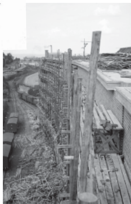
Kuva 16 PMK:n talo rakenteilla kesäkuussa 1937. Tasa-katto oli modernismin tuoma uusi rakennusratkaisu. Kuvan lähde Vapriikki
