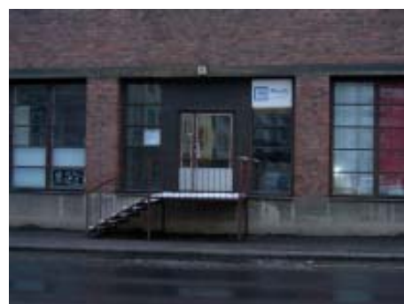
Kuvat 22 ja 23 Vuonna 1989 rakennettuja liiketilojen sisään- käyntejä Peltokadulla
