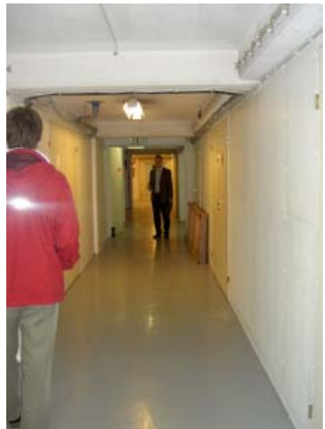
Kuva 39 Kopitettujen kerrosten keskikäytävä. Seinät maalattua kipsilevyä ja lattia maalattua betonia.
