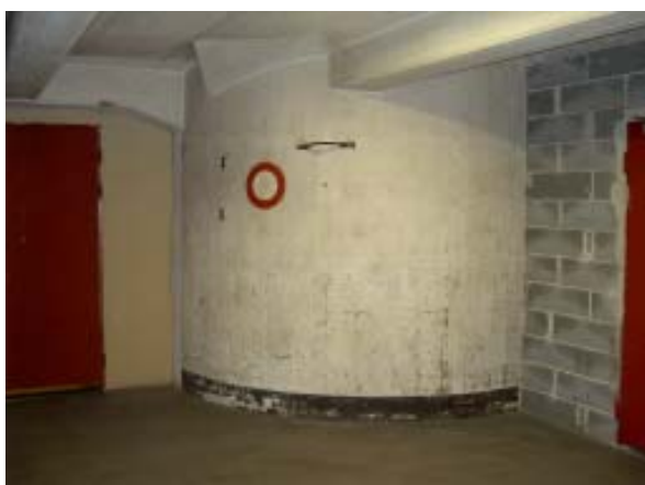
Kuva 42 Alimpia kerroksia yhdistäneitä liukuratakuiluja oli kaksi. Liukuradan alkupää näkyy katonrajassa. Toiseen kuiluun on rakennettu teräsrakenteinen porras ensimmäisen ja toisen kerroksen välille. Toinen kuilu ei ole käytössä.
