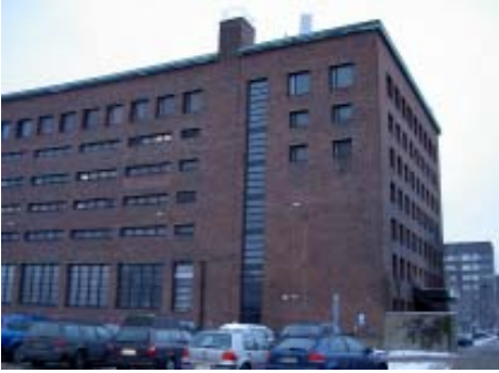
Kuvat 17 ja 18 Sodan jälkeen toimisto-osan neljäs kerros muutettiin asunnoiksi ja niitä varten puhkaistiin kaksi uutta ikkunaa
