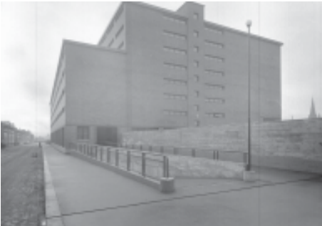
Kuva 19 Pohjoispääty ja autoluiskat Kuvaaja Mauno Mannelin 13.11.1937. Kuvan lähde Vapriikki
