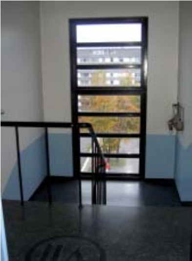
Kuva 27 Pääporrashuone Peltokadun puolella. Mosaikkibetonilattia kerrosnumerointineen ja portaan ilmava kaide ovat säilyneet muuttamattomina. Porrashuoneiden pystysuuntaiset nauhaikkunat on uusittu umpiolasi-ikkunoina.
