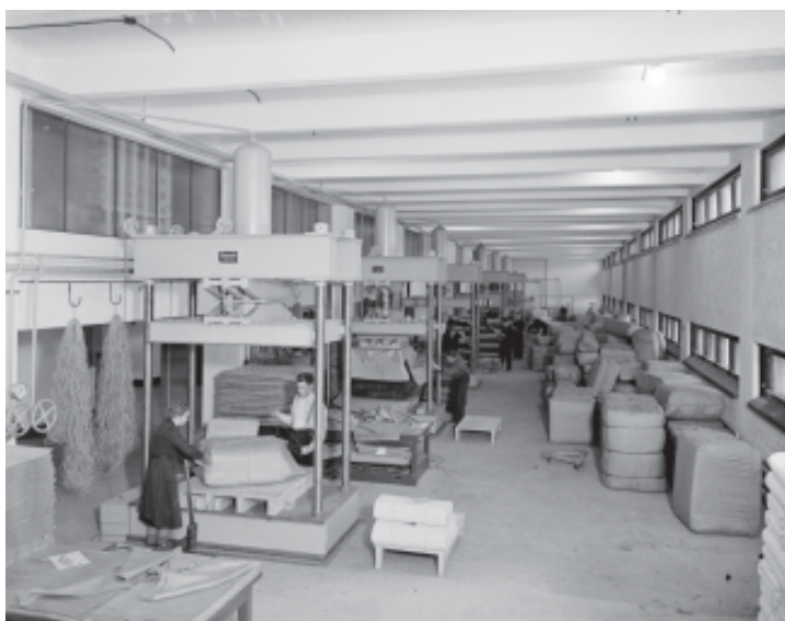
Kuva 10 Pakkaamon toimintaa. Pakkaamossa oli kuusi prässä, joilla niille ladotut kangspakat puristettiin litteiksi, paperoitiin ja vahvistettiin paalivanteilla kuljetuksia varten. Valmiit paalit työnnettiin liukukuiluun, jota pitkin ne kulkivat kerrosta alem- mas lastausalueelle. Kuvaaja Mauno Mannelin. Kuvan lähde Vapriikki
