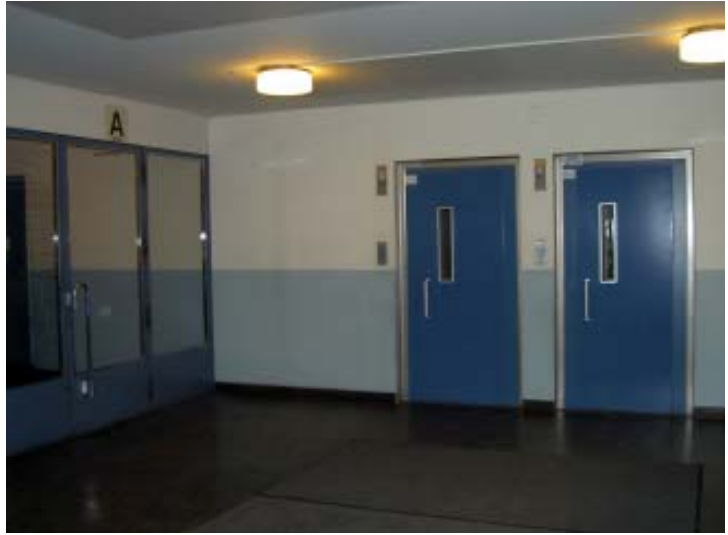
Kuva 29 Pääsisäänkäyntiaulassa porrashuoneisiin johtavat funktisvaikutteiset metalliovet ovat alkuperäiset. Hissien ovet ensimmäisessä kerroksessa on uusittu.
