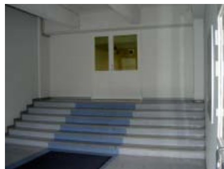
Kuva 69 Peltokadun sisäänkäyntiaulassa tilahierarkian ja rakennusosien suhde on ristiriitainen.
