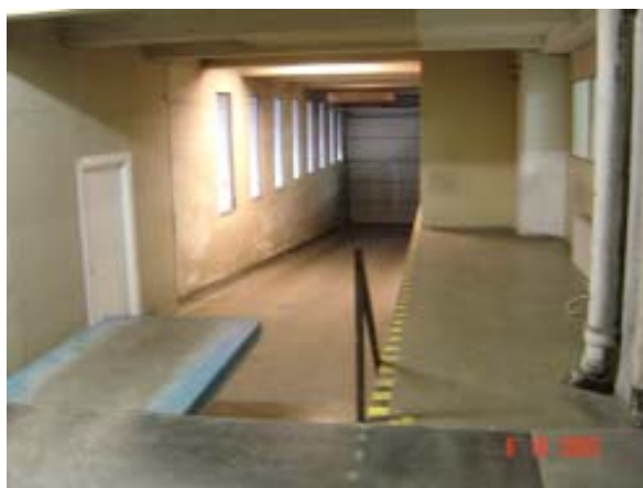
Kuva 41 Aikaisemmin ensimmäisen kerroksen lastauslaiturit ulottuivat koko itäjulkisivun mitalle. Nyt lastausalue katkeaa nousurampin jälkeen ja itäreunan tilat on muutettu liiketiloiksi.
