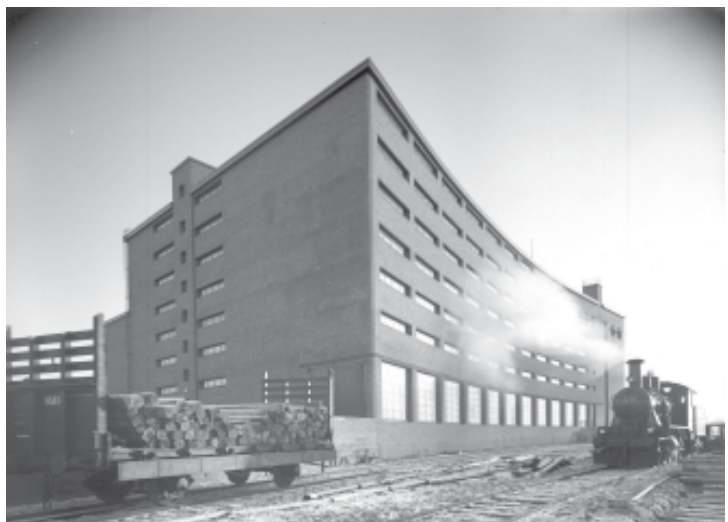
Kuvat 5 ja 6 PMK:n talon kaareva länsijulkisivu vasta- valmistuneena 27.11.1937. Toimistohuoneiden ikkunoissa oli liialta auringonpahteelta suoja- avat markiisit. Kuvaaja Teuvo Mäkinen. Lähde Vapriikki
