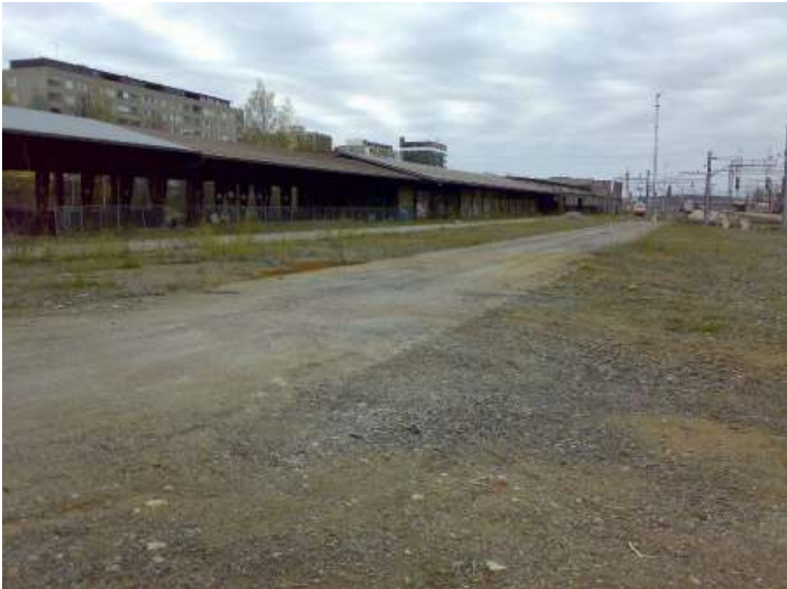
Kuva 3. Pyydyssarja 3:n sijoituspaikka sijaitsee ratapihan katos/varastorakennuksen sivustalla.
