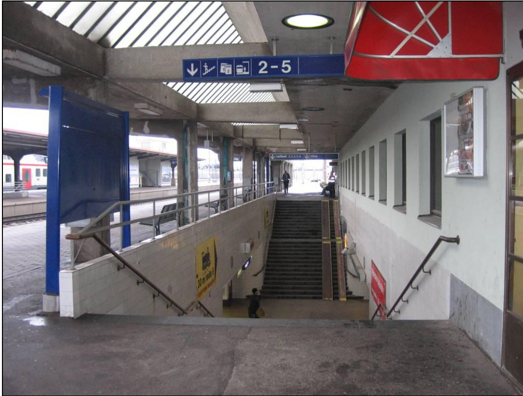
Reunalaiturikatoksen porrasmousujen päällä oleva valokateosio
