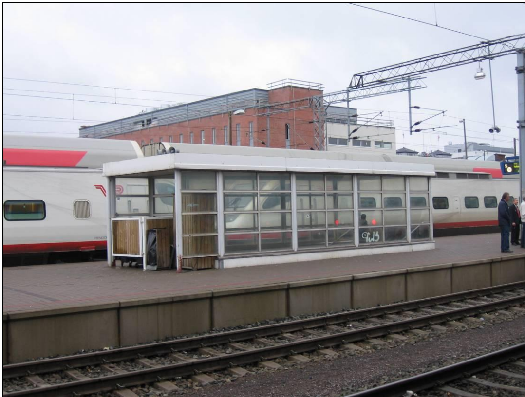
Toisen välilaiturin porrastouksen katos
