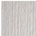
sokkelit harjattu betoni
