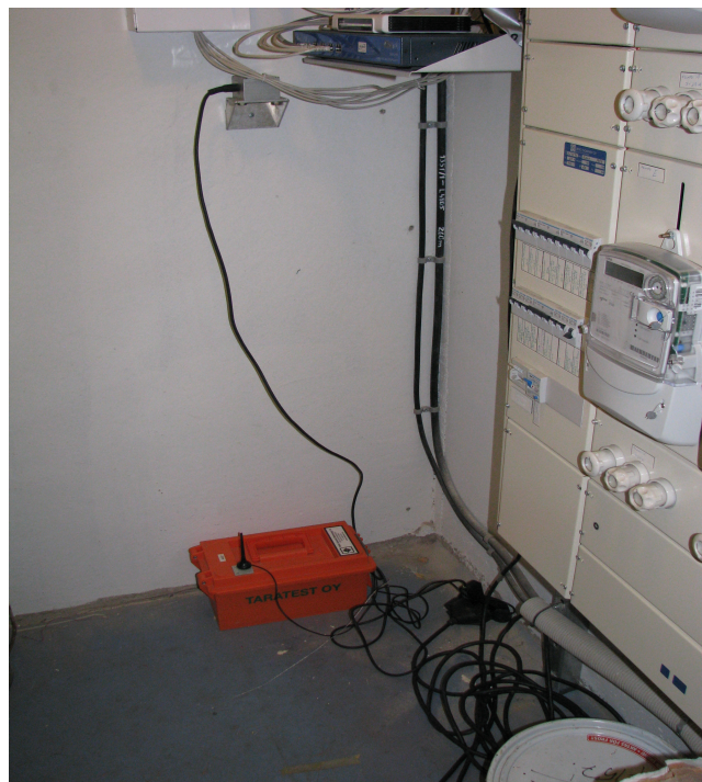
Kuva 1: Etäluettava mittauspiste maanpaineseinässä.
