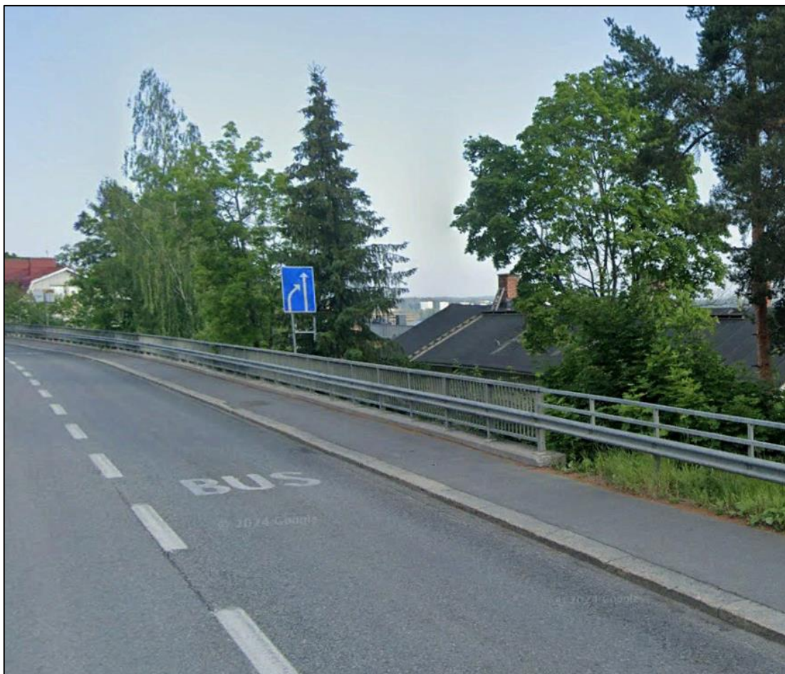
Kuva 8. Ratakadun kohdalla Pispalan valtatiellä nykytilanteessa sijaitseva kaide.
