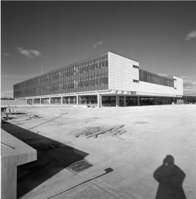
717 : A:6305 Tampereen kauppaoppilaitoksen uusi rakennus valmistumassa Kalevaan Juhani Riekkola 24.08.1965
