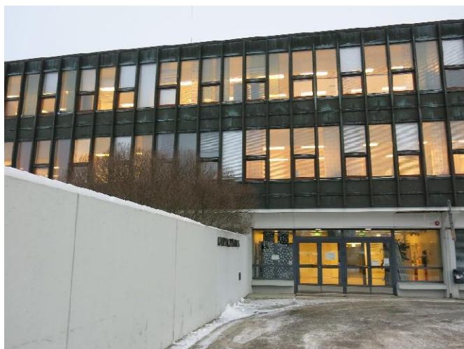
Kyy 166 : 115 TREDU Sammonkatu, päärakennuksen länsipuolen sisäänkäynti. Vasemmalla sivurakennuksen kauppaoppilaitokseen yhdistävää betonimuuria. Mirkku Haapasaari 24.11.2015
