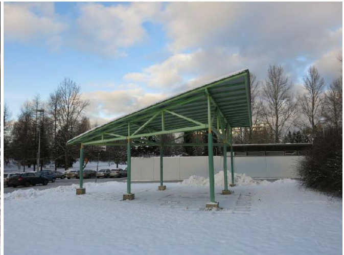
Kyy 166 : 120 Tredu Sammonkatu. Vuonna 2001 rakennettu tupakkakatos. Mirkku Haapasaari 24.11.2015
