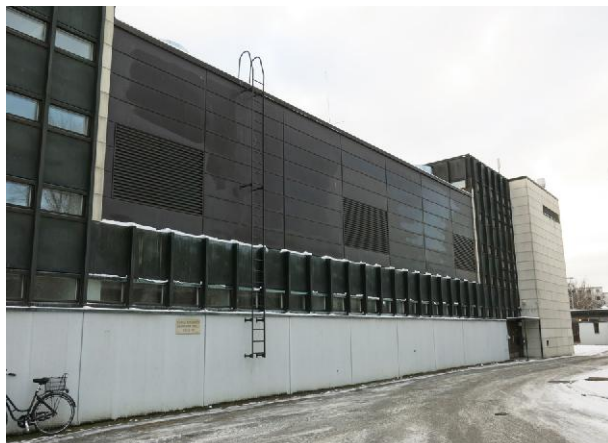
Päärakennuksen pohjoisjulkisivu ennen muutoksia (yllä) ja iv-konehuoneen lisäämisen jälkeen. (Ylempi valokuva kirjasta Tampereen kantakaupungin rakennuskulttuuri -> alkup. lähde: Tampereen kaupunginarkisto, kuvaaja: J. Antila 1981)
