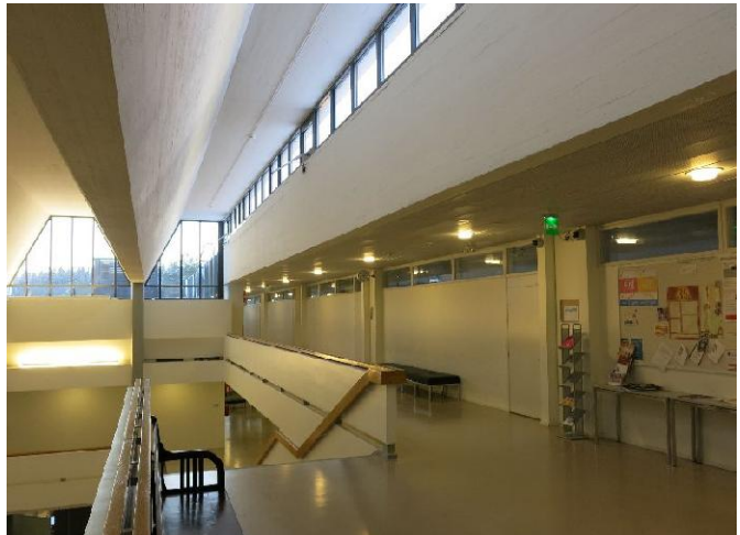
Kyy 166 : 109 TREDU Sammonkatu, päärakennus. Pääaulan kattoikkunoita. Portaat laskeutuvat 2. kerrokseen. Mirkku Haapasaari 24.11.2015
