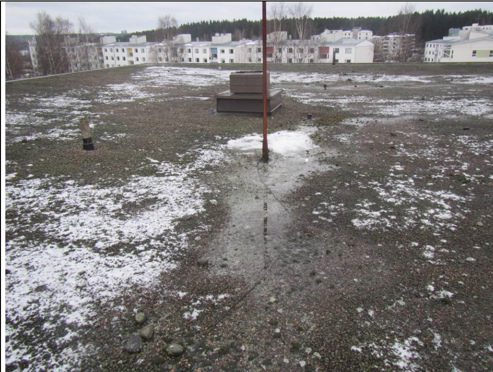
Kuva 15. Yleiskuvaa rakennuksen 3. kerroksen katolta.
