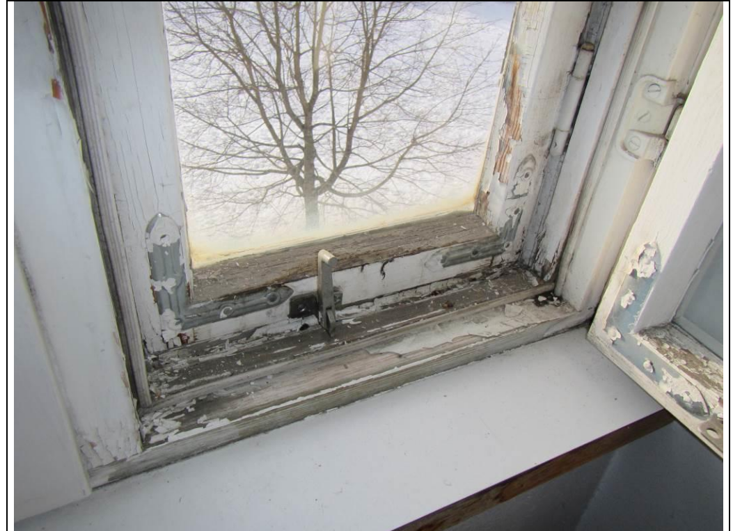
Kuva 12. Yleiskuva rakennuksen ikkunoista.
