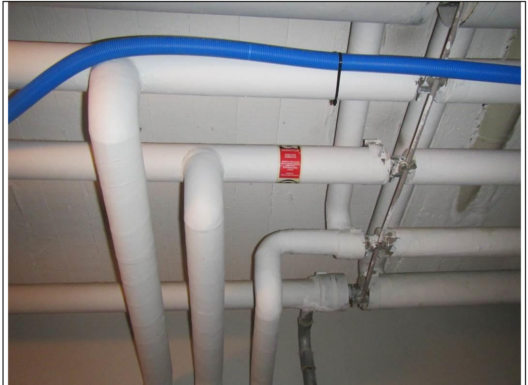
Kuva 36. Putkistomaadoitus
