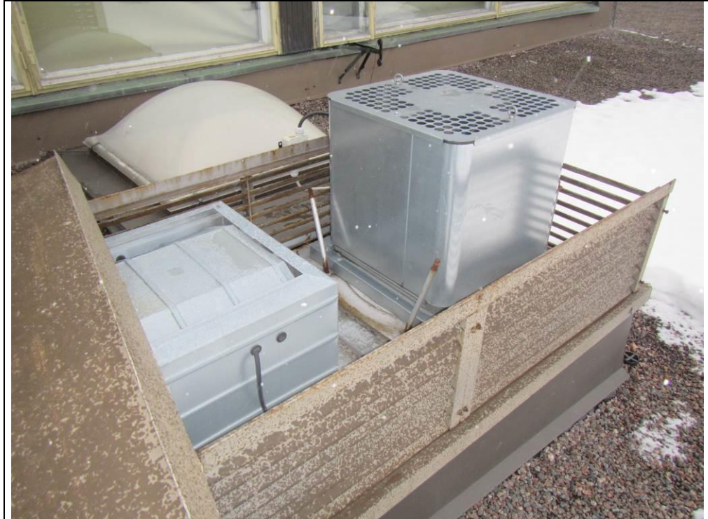
Kuva 32. Poistokoneita.
