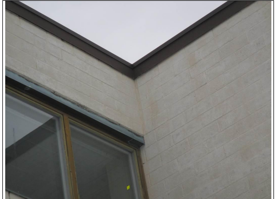
Kuva 8. Liitoskohdissa vesivauriojälkiä.
