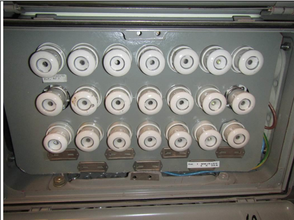
Kuva 35. Sulaketaulut
