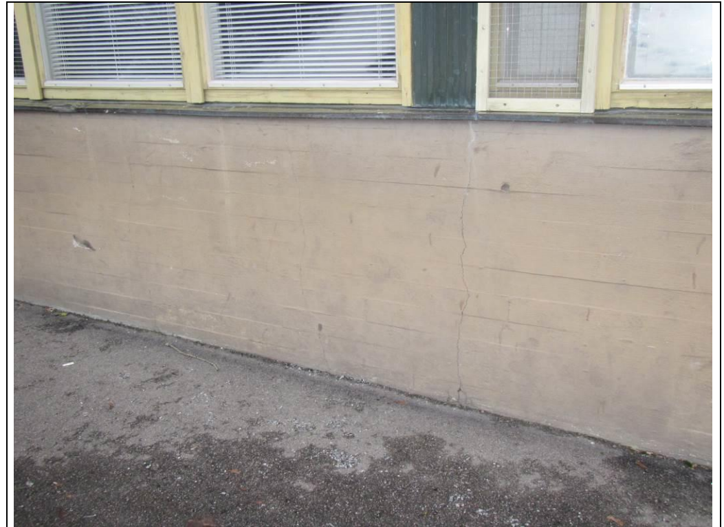
Kuva 6. Sokkelin halkeamia.
