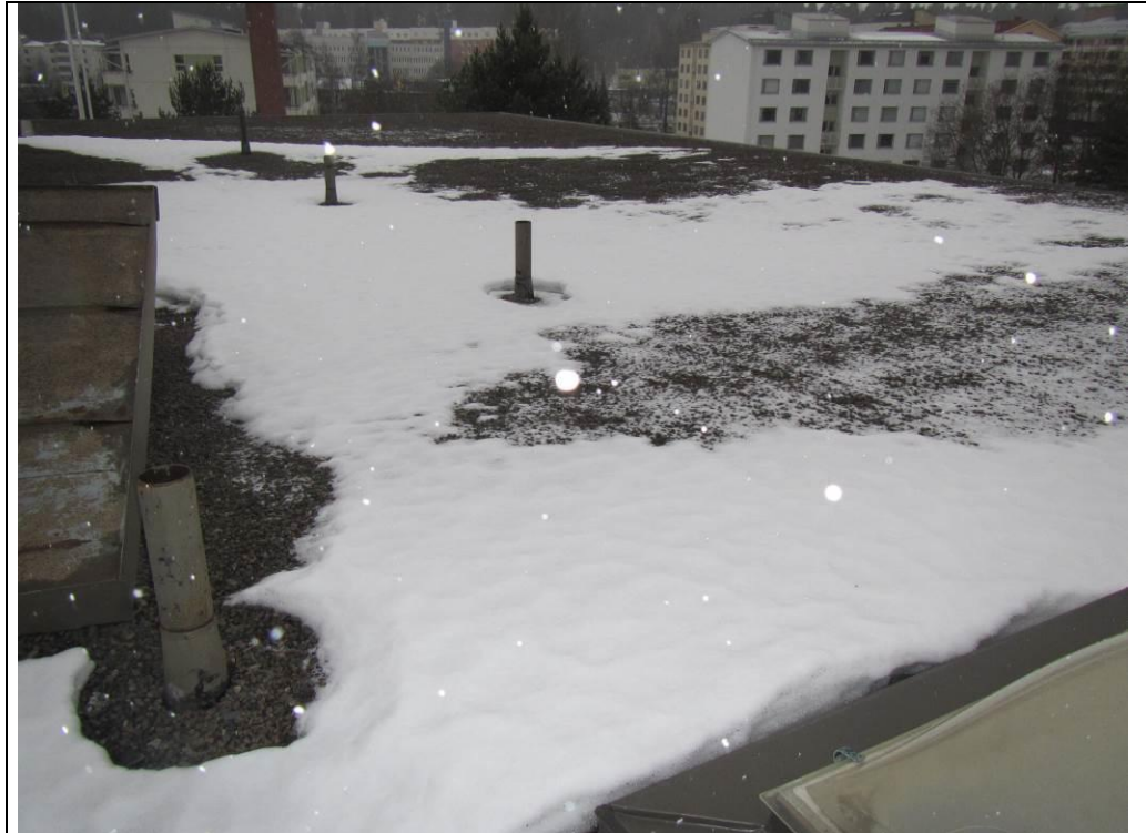
Kuva 14. Yleiskuvaa rakennuksen 2. kerroksen katolta.
