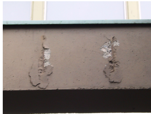
Kuva 5.1: Eteläjulkisivua ja itäjulkisivun sisäänkäyntikatoksen raudoituksia
