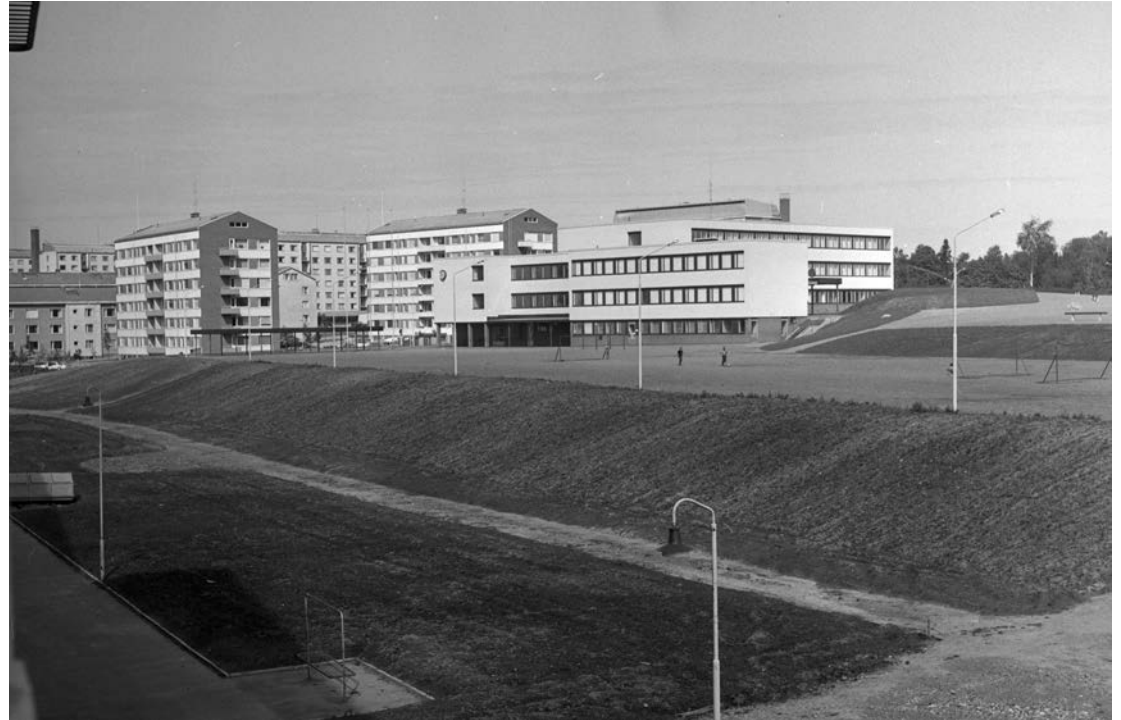
Kuvat 4.3: Koulurakennus ympäristöineen kaakosta vuonna 1965
