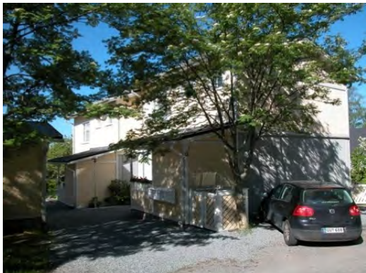
5. Hirvikatu 14 rivitalot koillisesta (rak. 1989).
