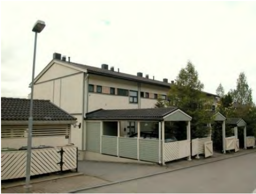
23. Selininkatu 1 rivitalot koillisesta (rak. 1981).
