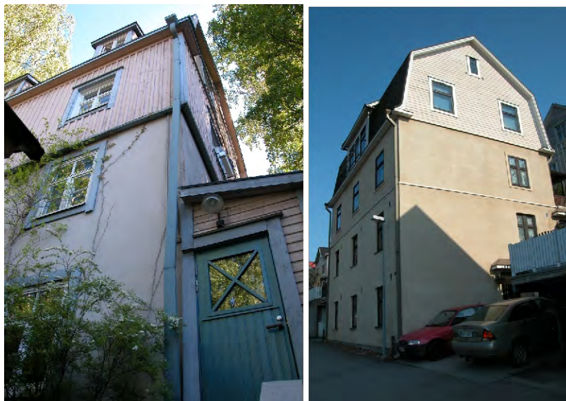
Rinteen jyrkkyydestä johtuvia Pispalalle tyypillisiä rakennusteknisiä ratkaisuja.
