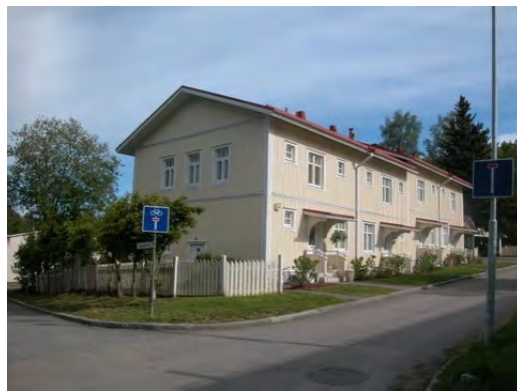
10. Jalajakatu 2 a rivitalo etelästä (rak. 1999).
