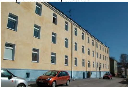
Osin betonirunkoinen, julkisivuiltaan rapattu pienkerrostalo Vallikadulla.
