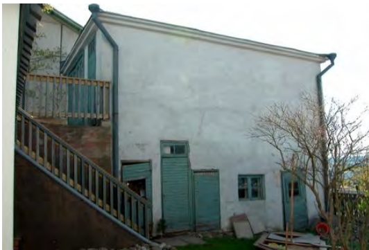
Betoninen piharakennus Pispalanharjulla.
