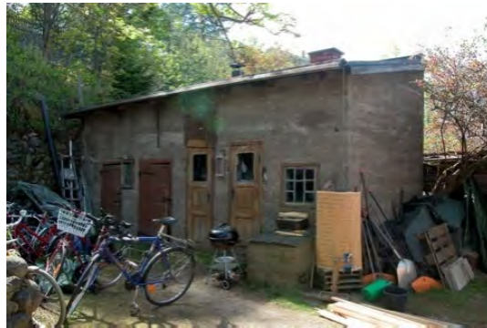
Säästöbetoninen piharakennus Rajaportinkadulla.
