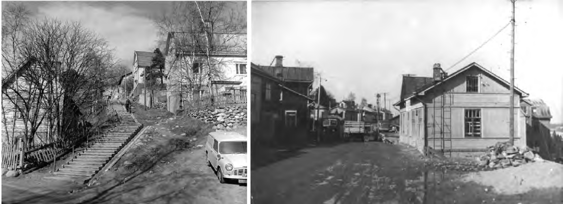
Vasemmalla Päivölänkadun betoniportaat 1950-60-luvulla. Oikealla Pispalan valtatie levennystöitä 1950-luvulla. Oikean reunan rakennus, ns. Vanamon kauppa purettiin levennyksen tieltä. Kuvat: Tampereen museoiden kuva-arkisto.
