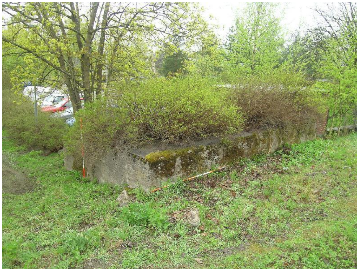
DSCN0303.JPG Pispalan tukkitie 1, betonirakenne. Koillisesta. 7.5.2008, Vadim Adel.
