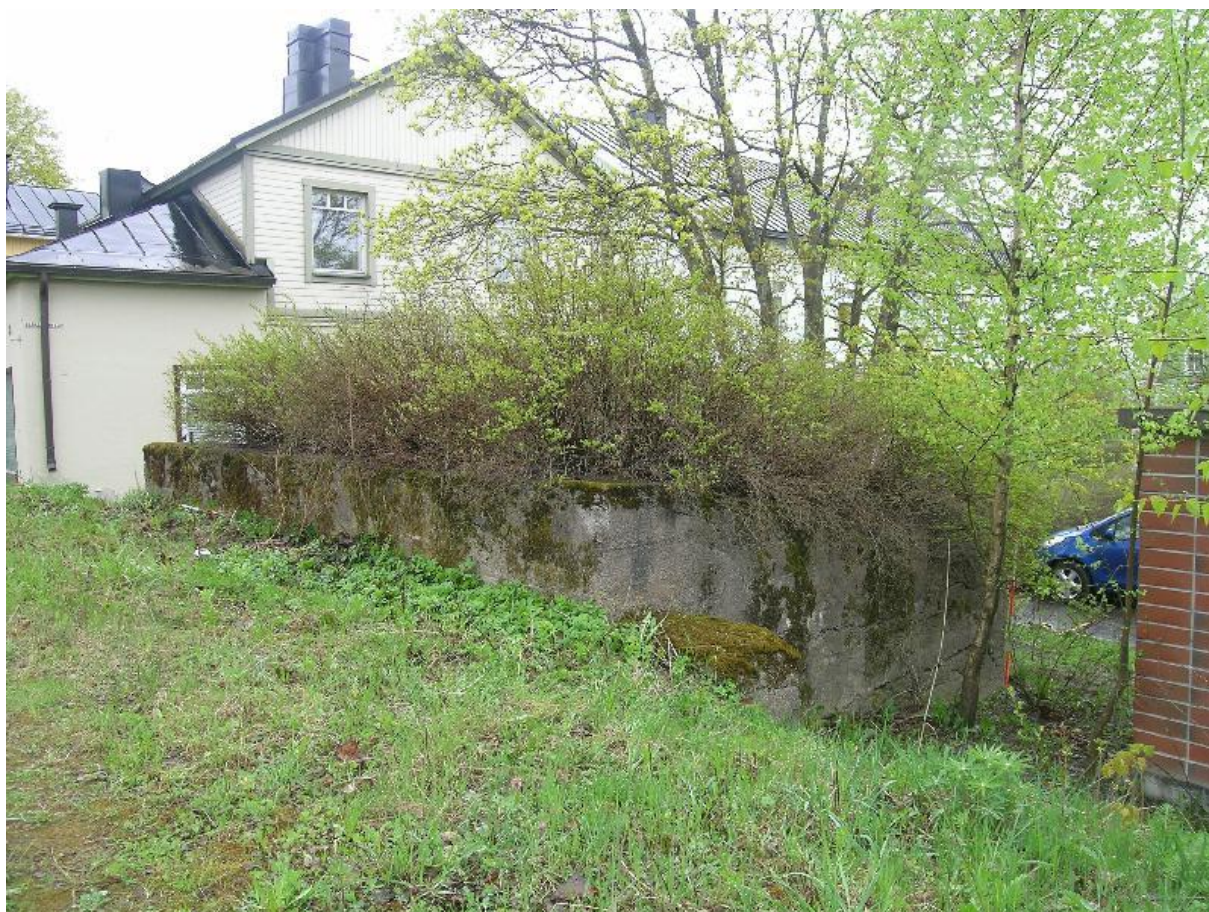
DSCN0305.JPG Pispalan tukkitie 1, betonirakenne. Luoteesta. 7.5.2008, Vadim Adel.
