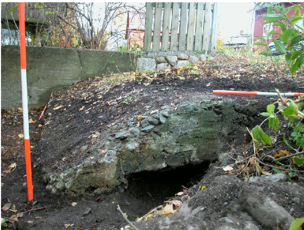
DSCN0015.JPG Betonirakenteen SW-sivua (NW-osa). SW, 6.10.2008, Vadim Adel.
