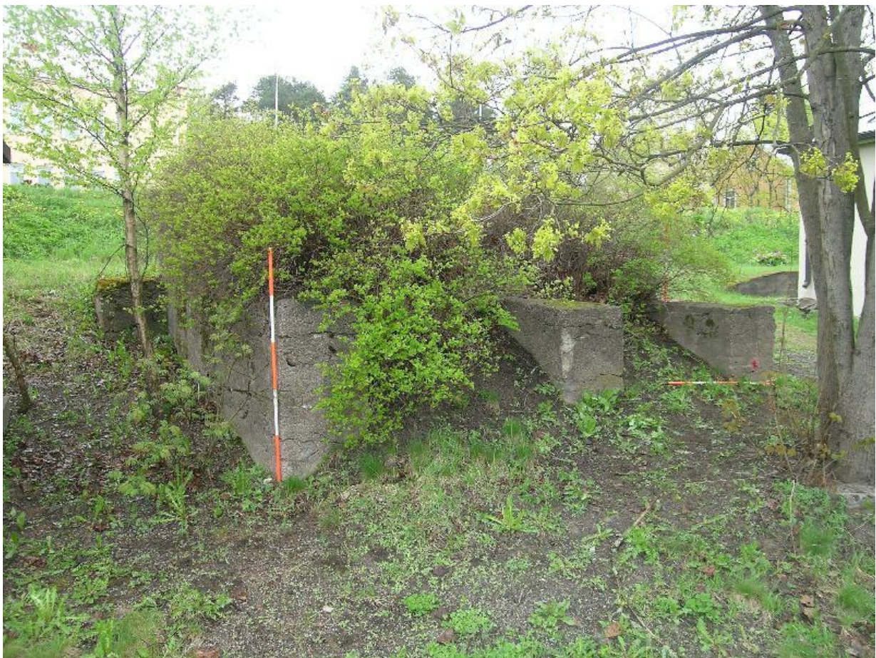
DSCN0300.JPG Pispalan tukkitie 1, betonirakenne. Lounaasta. 7.5.2008, Vadim Adel.
