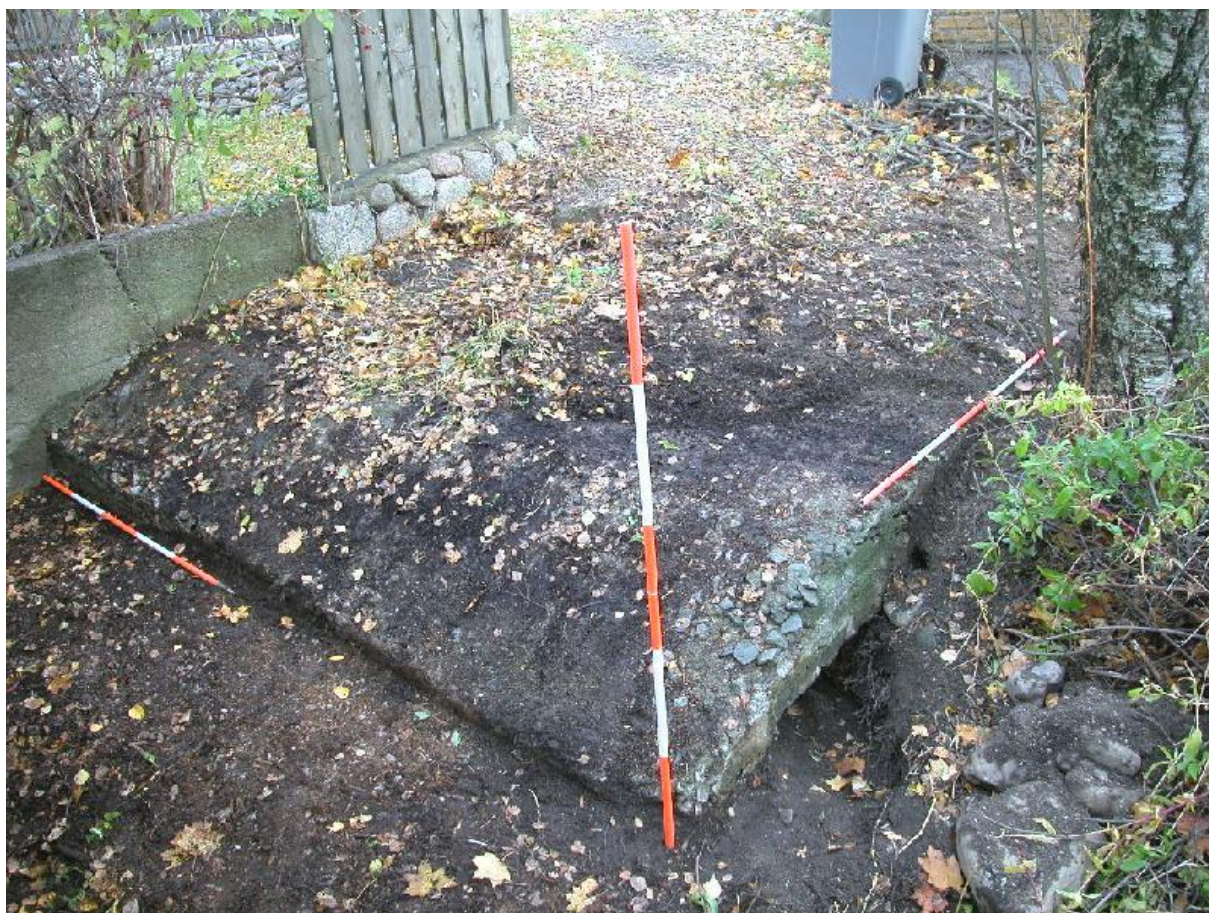
DSCN0014.JPG Yleiskuva betonirakenteesta. WSW, 6.10.2008, Vadim Adel.
