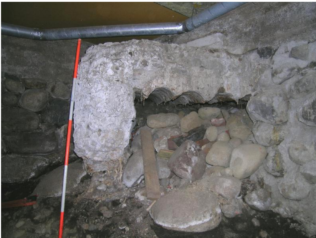
DSCN0386.JPG Pispalanharju, Pispalanharju 34. Betonirakenne. Itäkoillisesta. 14.5.1008, Vadim Adel.
