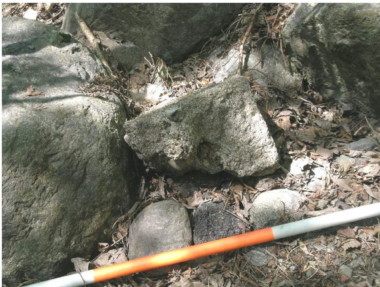
DSCN0340.JPG Susikolunpuisto. Betonisen rakenteen osa. 12.5.2008, Vadim Adel.
