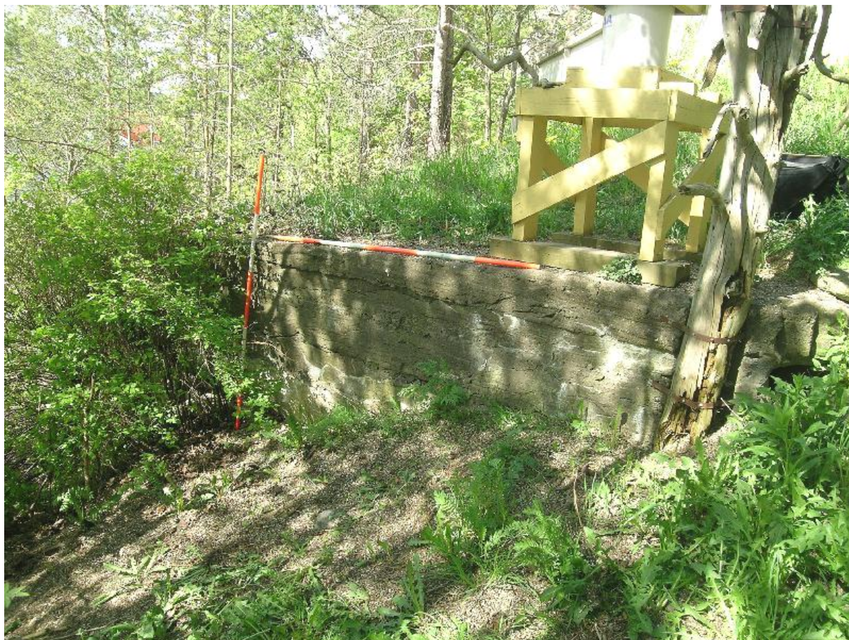
DSCN0354.JPG Pispalan koulu. Rakenne 1. Kaakosta. 12.5.2008, Vadim Adel.
