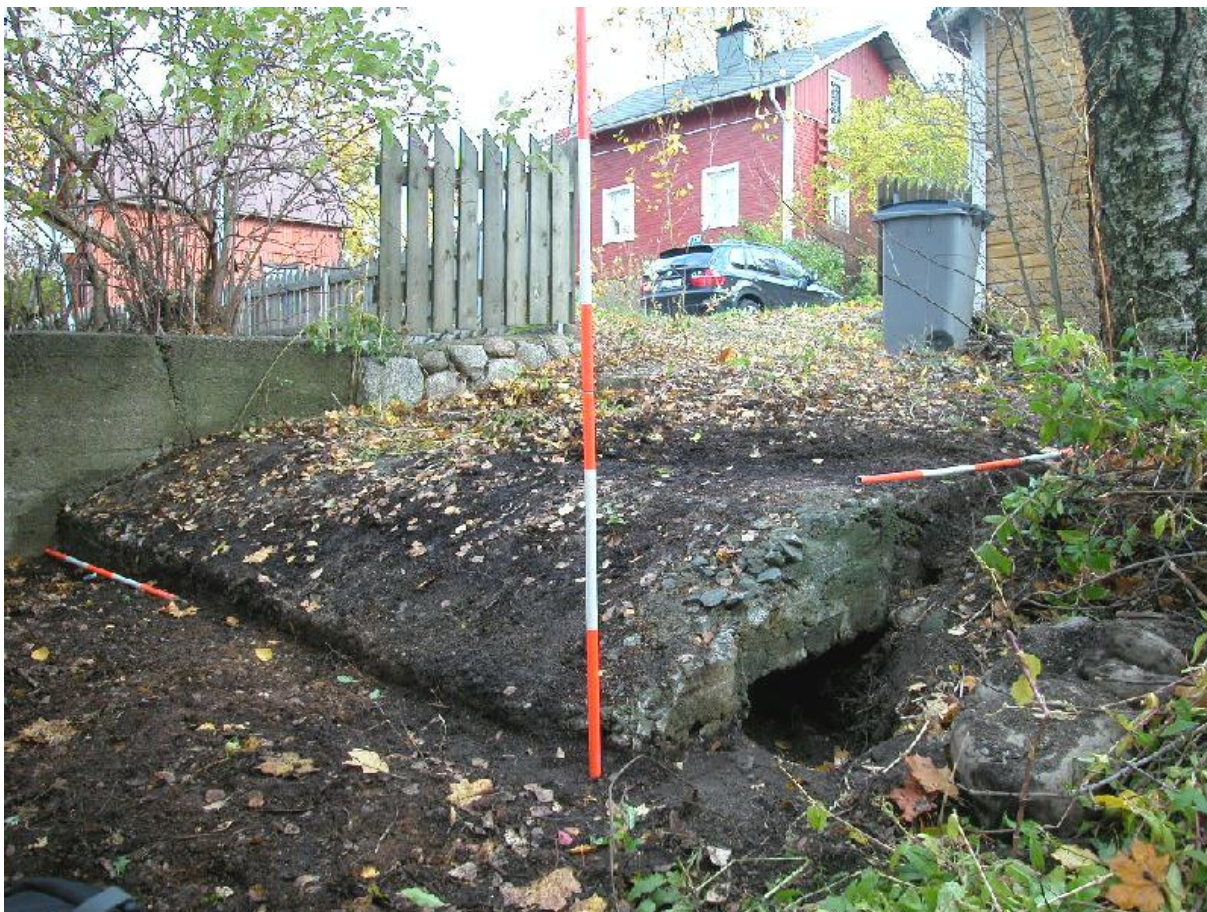
DSCN0012.JPG Betonirakenne. WSW, 6.10.2008, Vadim Adel.
