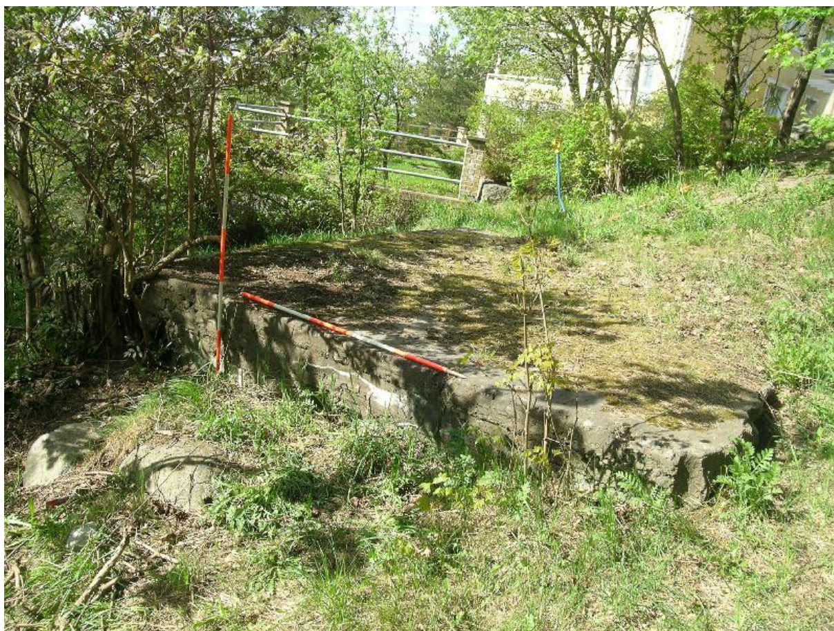
DSCN0355.JPG Pispalan koulu. Rakenne 2. Kaakosta. 12.5.2008, Vadim Adel.
