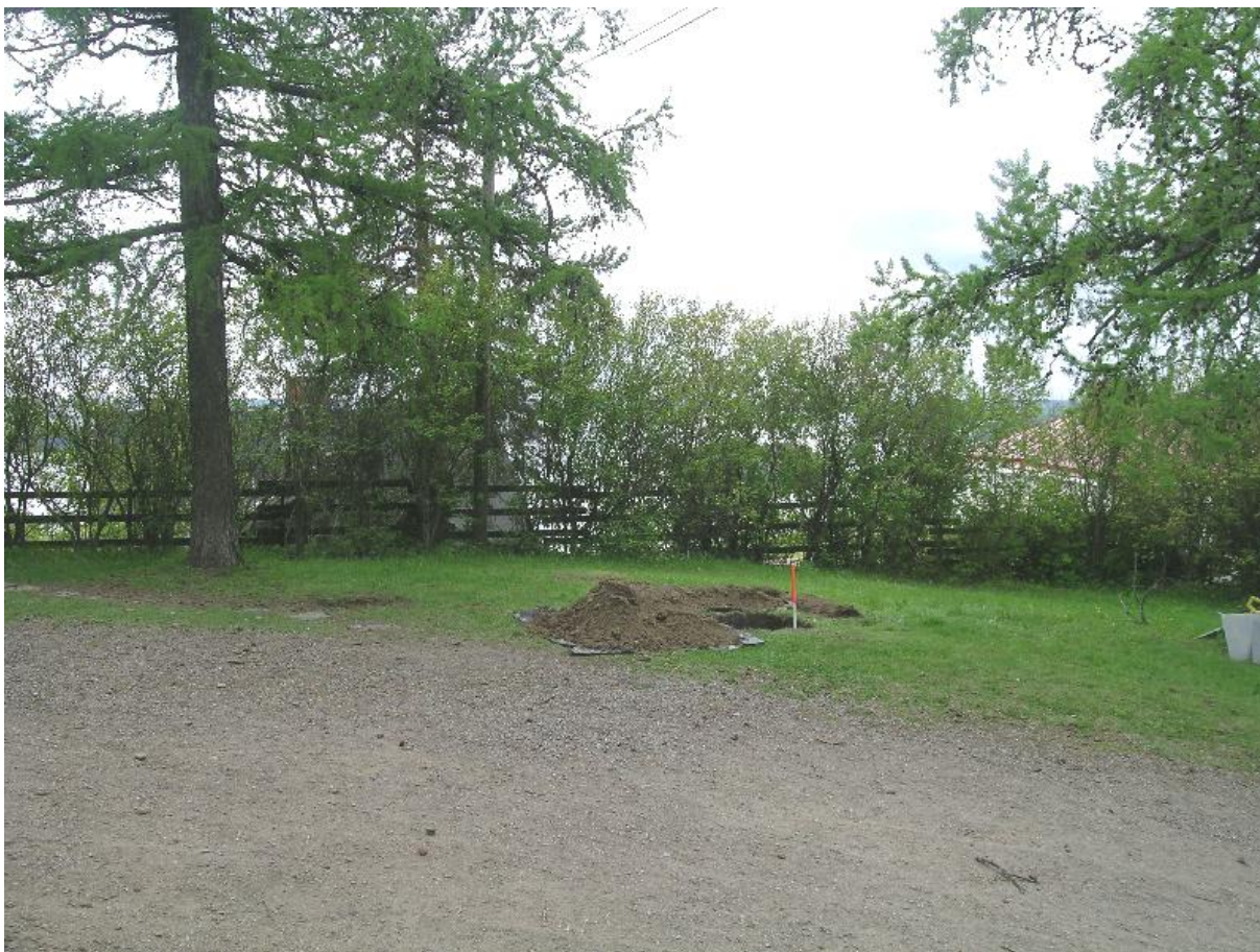
DSCN0409.JPG Pispalanharju, "Pyykkimetsä", betonirakenteen paikka. Linjakeppi on kk 4:n N-kulmassa. Koillisesta. 20.5.2008, Vadim Adel.
