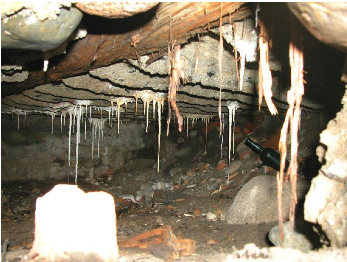
DSCN0011.JPG Betonikattoisen rakenteen sisätilaa/katon sisäpuolta. SW, 6.10.2008, Vadim Adel.
