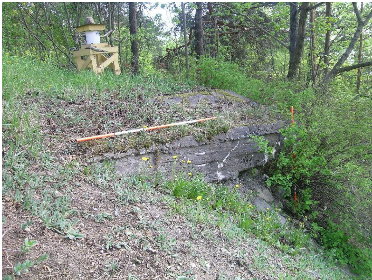
DSCN0347.JPG Pispalan koulu. Rakenne 1. Koillisesta. 12.5.2008, Vadim Adel.
