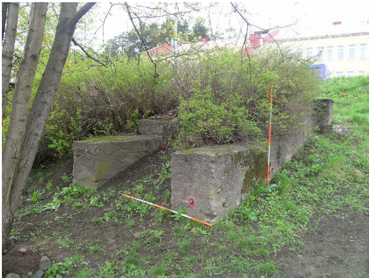
DSCN0301.JPG Pispalan tukkitie 1, betonirakenne. Kaakosta. 7.5.2008, Vadim Adel.
