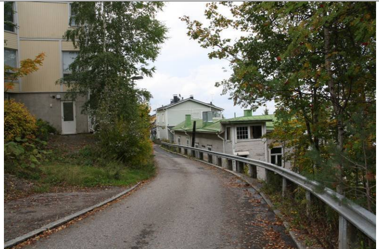
Kuva 43. Rinnekatu 2, purettava rakennus.
