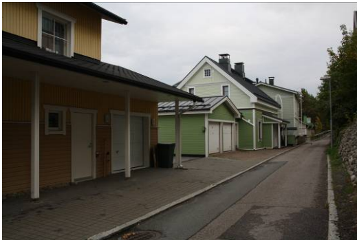
Kuva 40. Rinnekadun itäosa on jo merkittävästi uudistunut. Huomionarvoista on, ettei purettava rakennus Rinnekatu 2 ei näy kauempana katsoen katunäkymässä.
