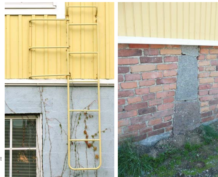
Materiaalit ja niiden yksityiskohdat vaikuttavat rakennuksen yleisilmeeseen.
