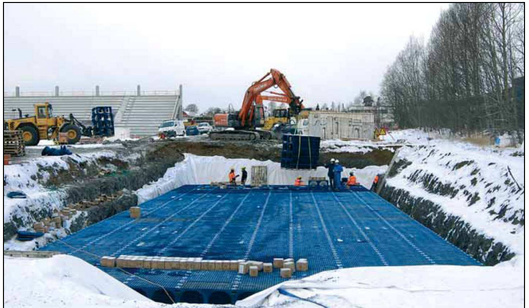
Kuva 9. Muovikennostolla täytetty maanalainen viivytyskaivanto 5 .
