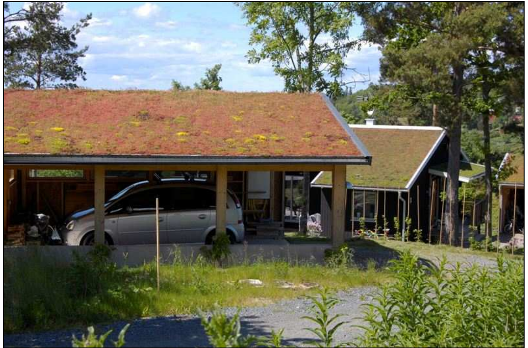
Kuva 11. Viherkattorakenne pientalokohteessa (Ruotsi, Huskvarna). Kuvassa olevan viherkaton kasvillisuus on sammal-maksaruohoa (Sedum). 9
