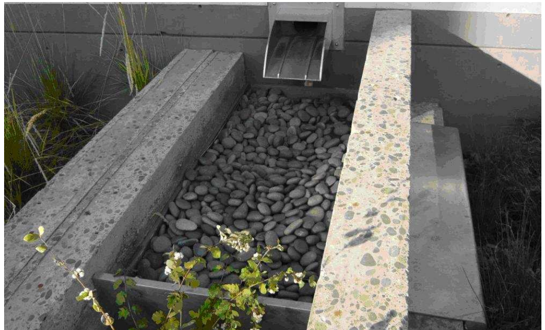
Kuva 16. Kivipesä syöksytorven yhteydessä (Portland Oregon). 6
