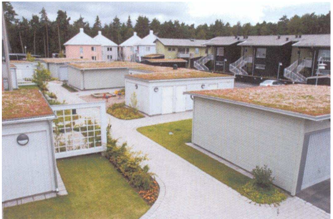
Kuva 12. Sammal-maksaruohokattoja rivitalokohteen (Ruotsi, Växjö) varastojen ja autotallien katoissa. 10
