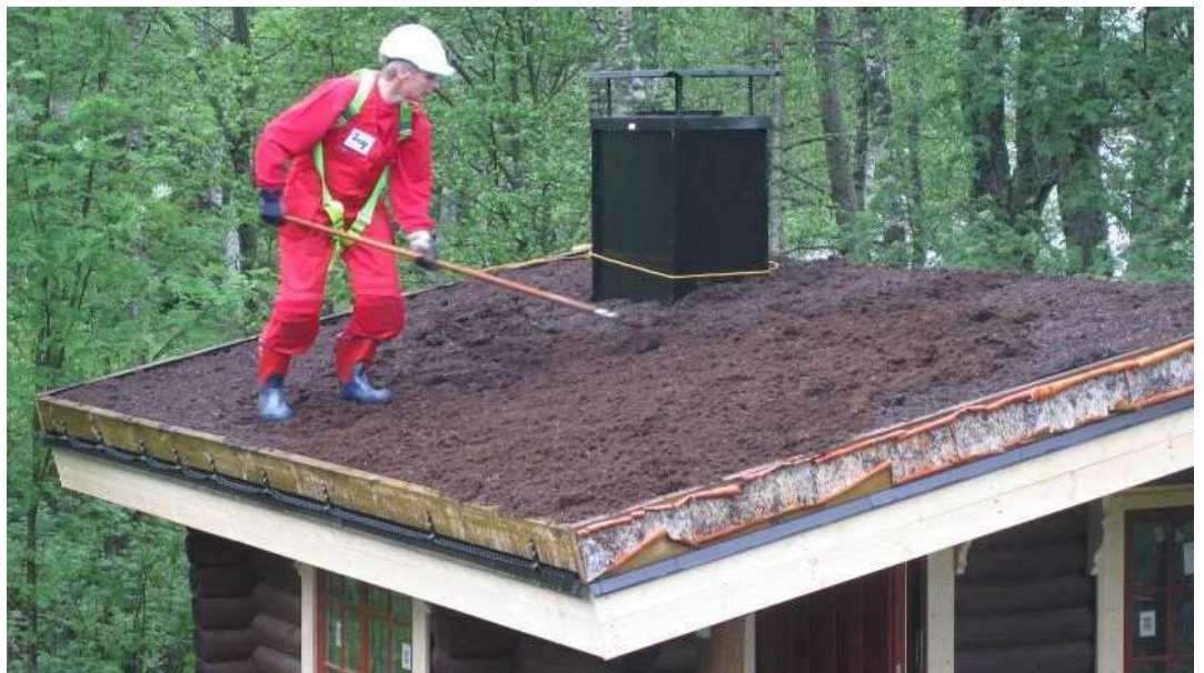
Kuva 14. Irtoturpeen levittämistä intensiivisen viherkaton kasvualustaksi. 11
