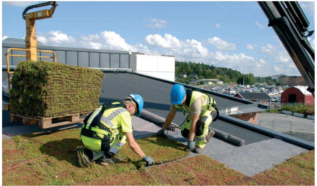
Kuva 13. Sammal-maksaruohomattojen asennusta. Vihermattojen alle on asennettu suodatinkangasta. 9
