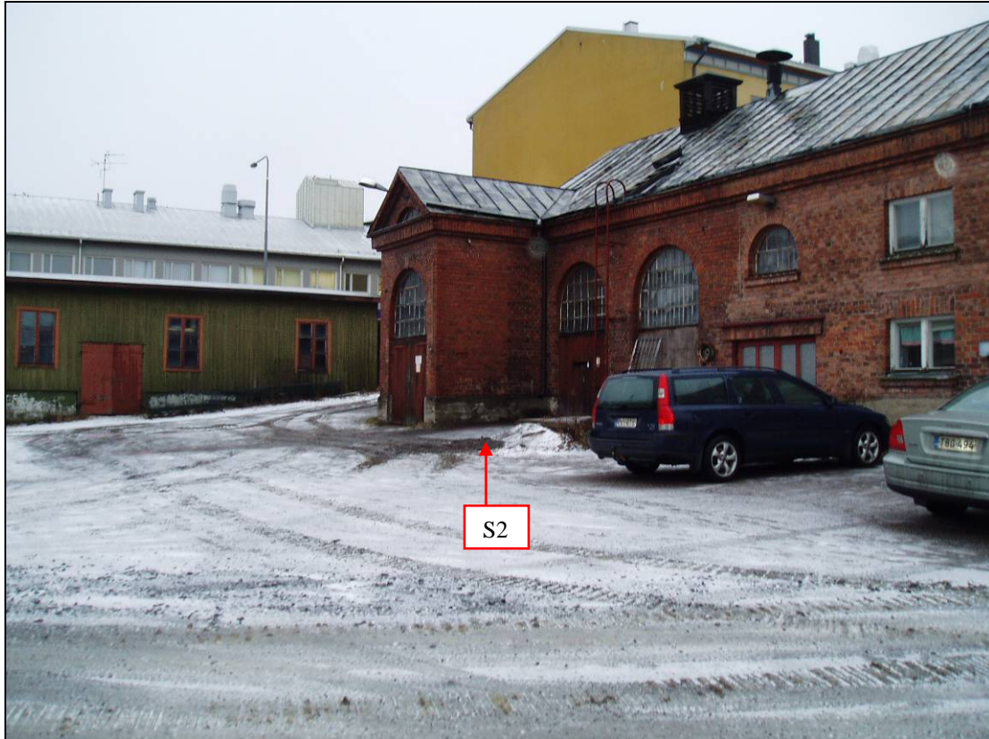
Kuva 3. Tutkimuspiste S2 kohteen pohjoisosassa. Sorinkatu vihreän, puurakententeisen rakennuksen takana.
