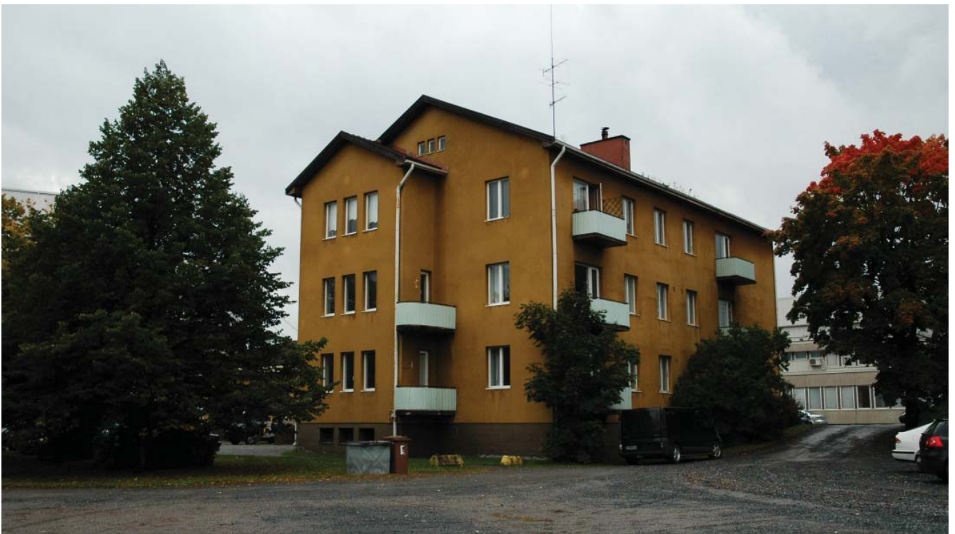
Kuva 53: Sorinkadun asuinrakennus radalta päin katsottuna. Kolmas asuinkerros on rakennettu muutama vuosi valmistumisen jälkeen.
