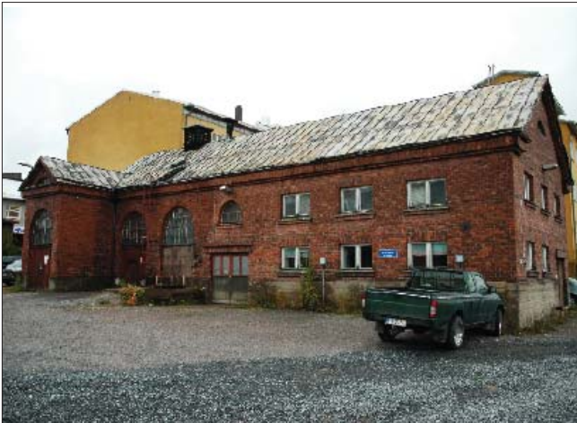
Kuva 25. Vanha kaasutehdas. Myöhemmin rakennettu muutos näkyy selvästi.
