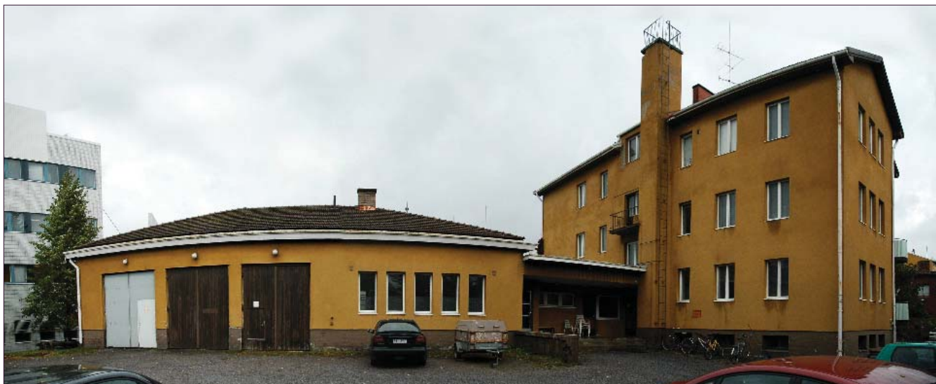
Kuva 51. Sorinkadun Rto:n huolto- ja asuinrakennus. Vasemmalla on yksikerroksinen huoltorakennus, jossa sijaitsee autohuoltotiloja ja sosiaalitylöitä. Oikealla alunperin 2-kerroksinen, sittemmin korotettu asuinrakennusosa. Rakennus on täystiilinen rapattu rakennus, jossa on tiilikatto ja puiset parvekkeet.
