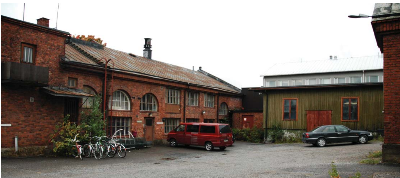
Kuva 47. Vanhojen tehdasrakennusten muodostama miljöö on tällä hetkellä varsin huonossa kunnossa.
