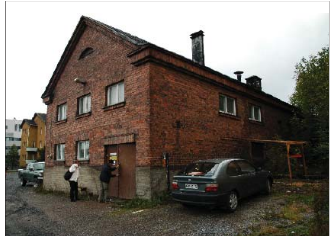
Kuva 26. Vanha kaasutehdas radalta päin. Laajennus radalle päin tehty v. 1949.
