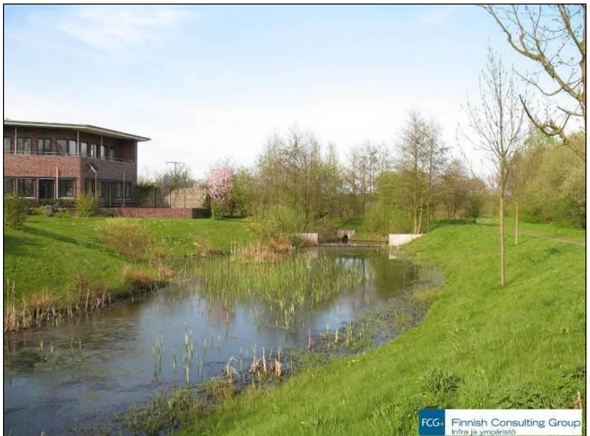
Kuva 9. Esimerkki laaja-alaisesta hulevesien viivytyksestä. Kuva on Hannoverista. 8
