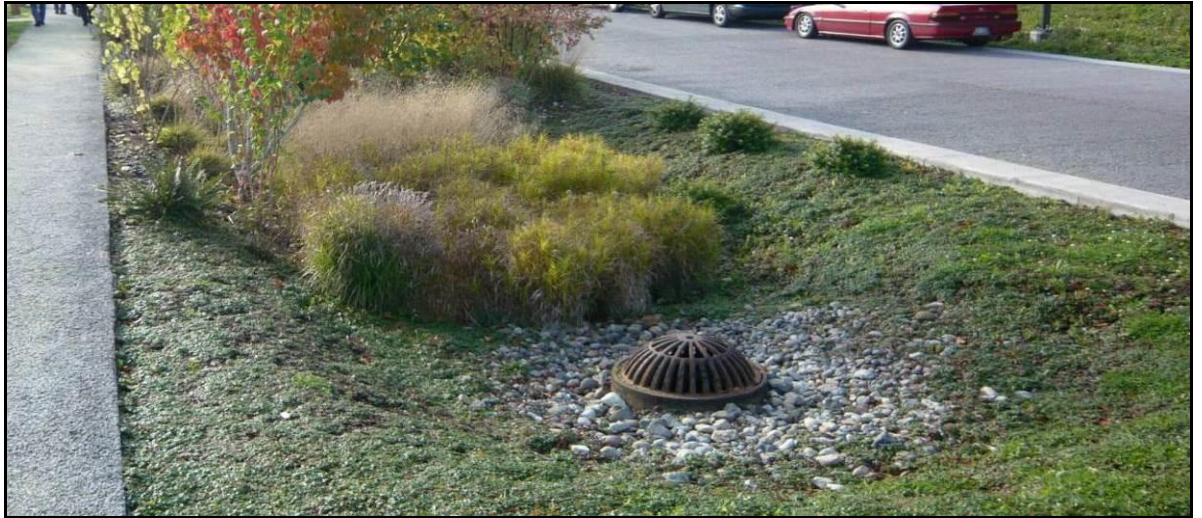
Kuva 12. Esimerkki ylivuotojärjestelmällä varustetusta viherpainanteesta. 8
