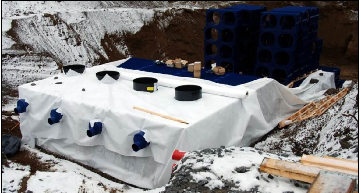
Kuva 8. Esimerkki maanalaisen kennoston rakentamisesta Tampereella. 8
