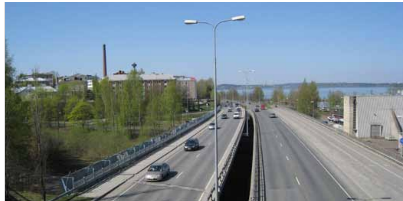
Kuva 11.6. Rantaväylä Armonkallion ja Naistenlahden voimalaitoksen kohdalla.
