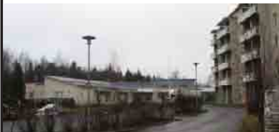
kuva 2222-5-1-1, kuvassa rakennukset 1 ja 2
